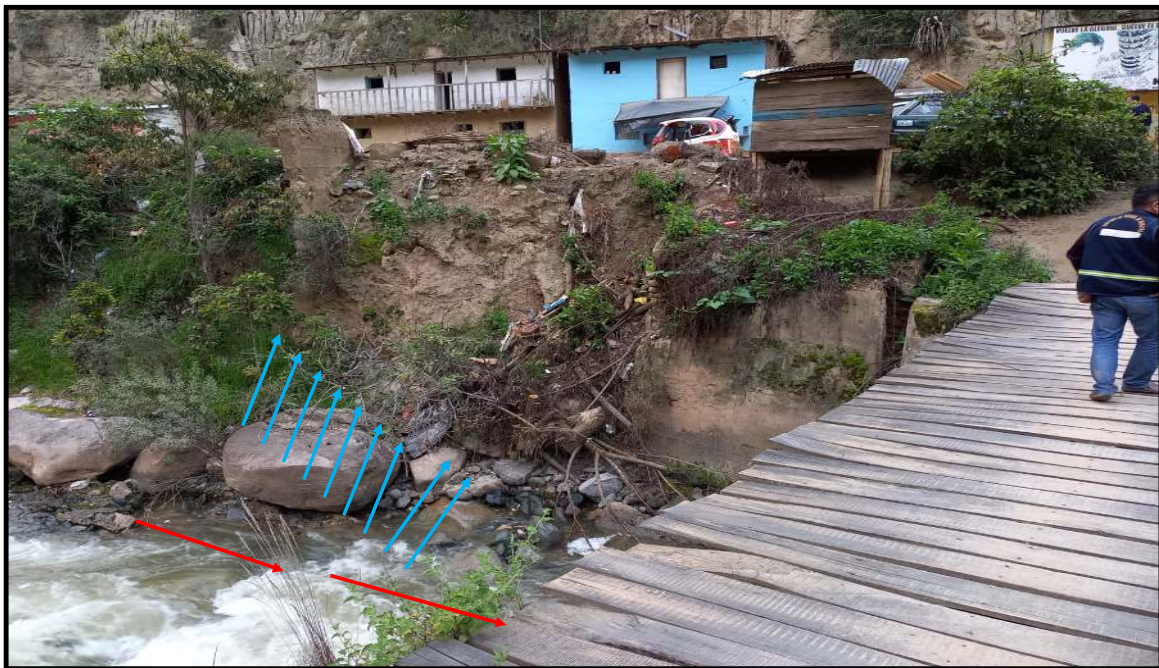
FIGURA N°03: EN LA TEMPORADA DE MAXIMAS AVENIDAS EN LA QUEBRADA SE OBSERVA LA SOCABACIÓN POR LA MARGEN DECHECHA, EN EL SECTOR COZOTINGOL, DISTRITO SAN PEDRO DE CHAULAN - HUÁNUCO - HUÁNUCO, CUYO TRAMO SE ENCUENTRA COLMATADO Y
